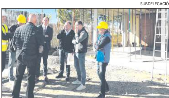
Visita d'obres al poliesportiu de Linyola
