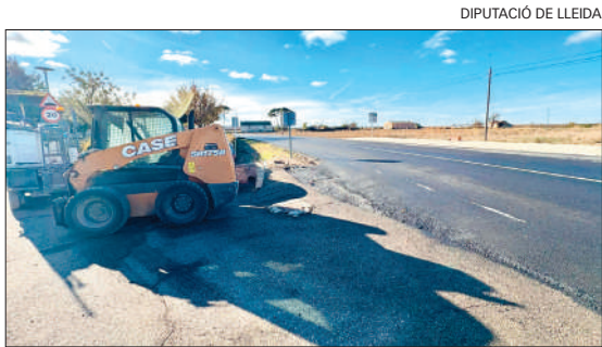
Treballs de millora del ferm a la carretera LV-3341
