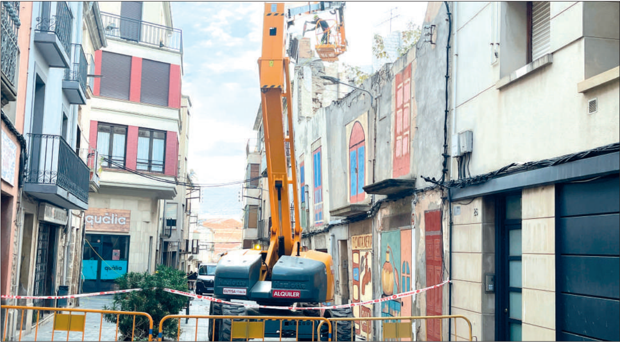
Els treballs urgents d'enderroc al carrer Urgell
