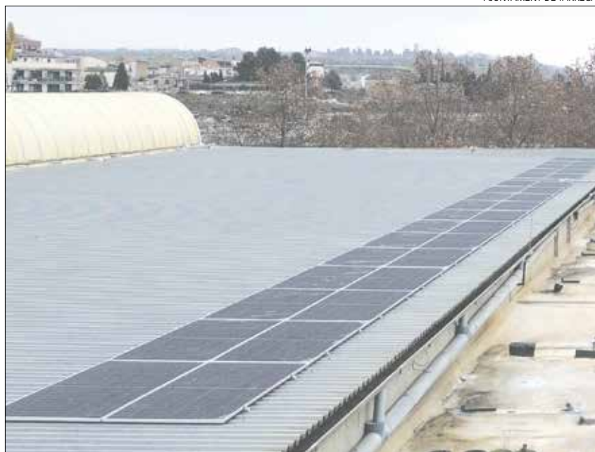
Les primeres plaques ja instal·lades a la coberta del Pavelló Municipal d'Esports.
