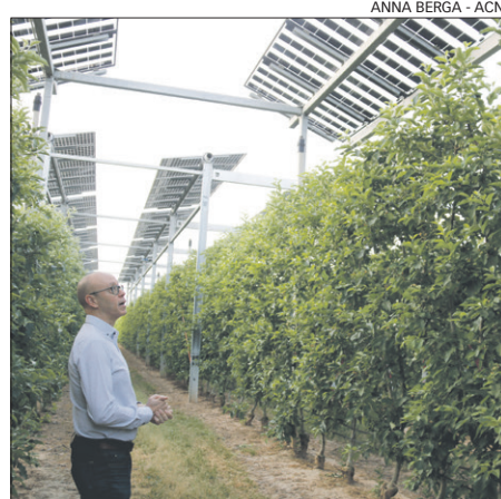
Panells fotovoltaics instal·lats en un camp de pomeres de Mollerussa
