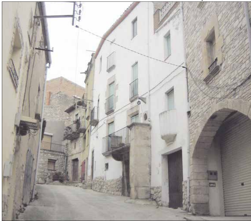
A Ciutadilla, quatre habitatges rehabilitats han permès l'arribada d'onze persones
