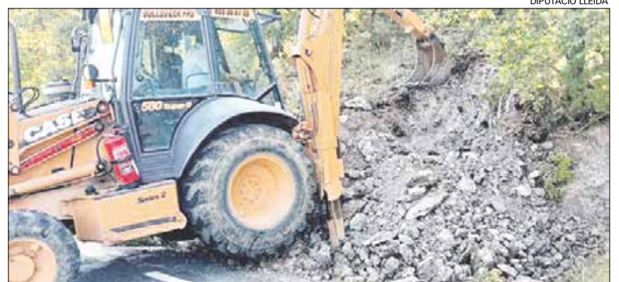
Imatge de la carretera LV-9042 entre les Avellanes i Santa Linya
